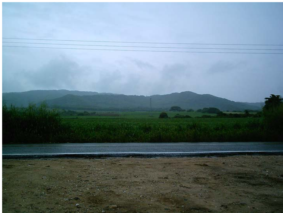
Km 204+000 (lugar donde entronca la Autopista y como se encuentra en la actualidad)
