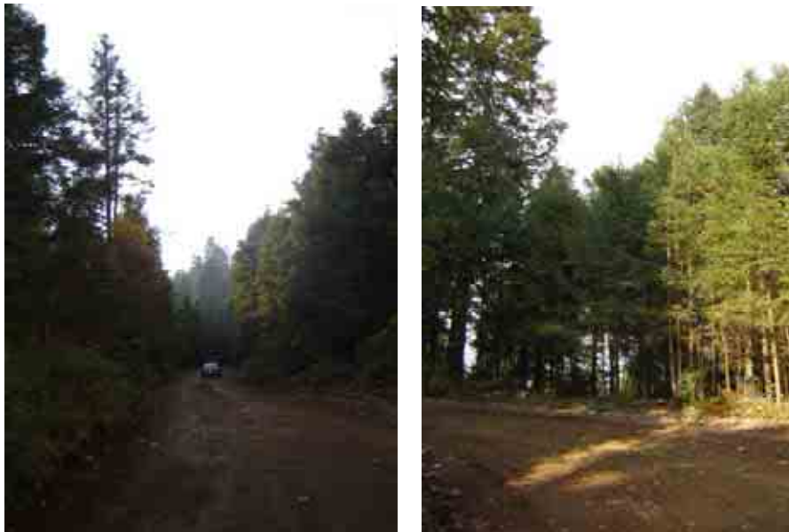
Fotos V.1.3-1. Escenarios de algunos de los caminos que se encuentran cerca del trazo bajo estudio, se recomienda su utilización.
