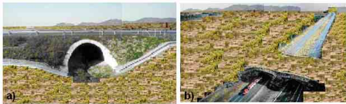
Figura VI.1.2.2.3. Pasos bajos y elevados para el paso de fauna silvestre
