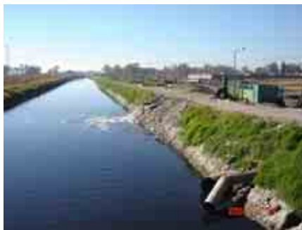
Vertido de aguas negras en canal Lerma
