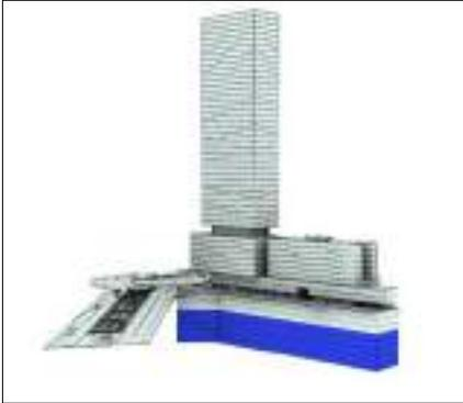
Los sótanos del -7 al -4 se ubicarán bajo el nivel de la calle con una altura de piso terminado a piso terminado de 3.35 m cada uno. Estos niveles serán destinados a estacionamiento público y se conectarán a través de 3 núcleos de circulaciones verticales para usuarios y 2 redes de rampas de ascenso y descenso para los automóviles.
