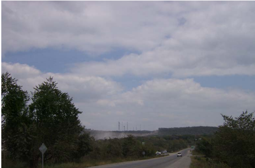
1. Al borde de la carretera que conduce a Tamuín, se ubican estos bancos de materiales, obsérvese las emisiones de polvos a la atmósfera.
