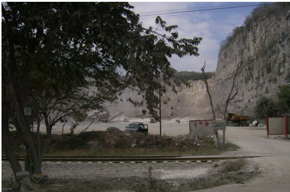
10. Nótese la profundidad de los bancos de extracción y de los accesos a los mismos.
