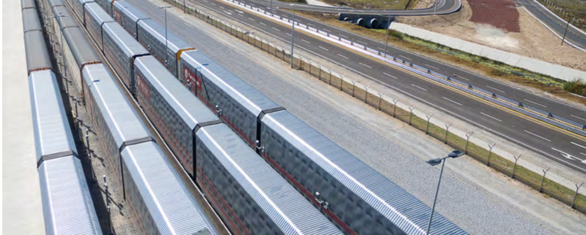
Terminal Automotriz, Puebla, México. //
