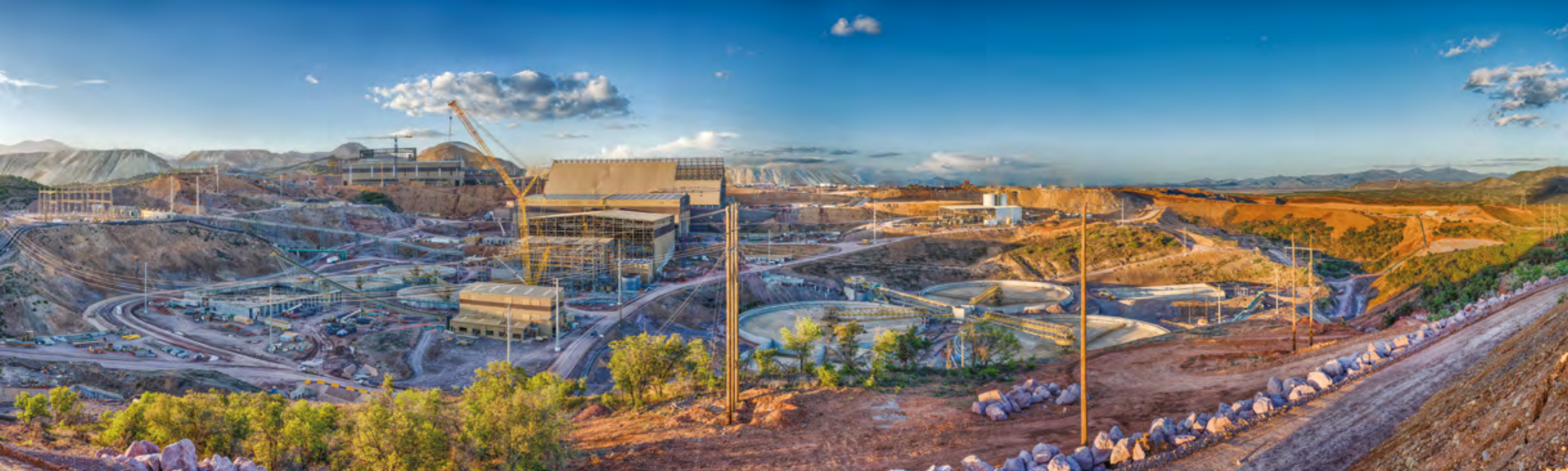
Construcción de la Concentradora II en Buenavista del Cobre, Sonora, México. //
