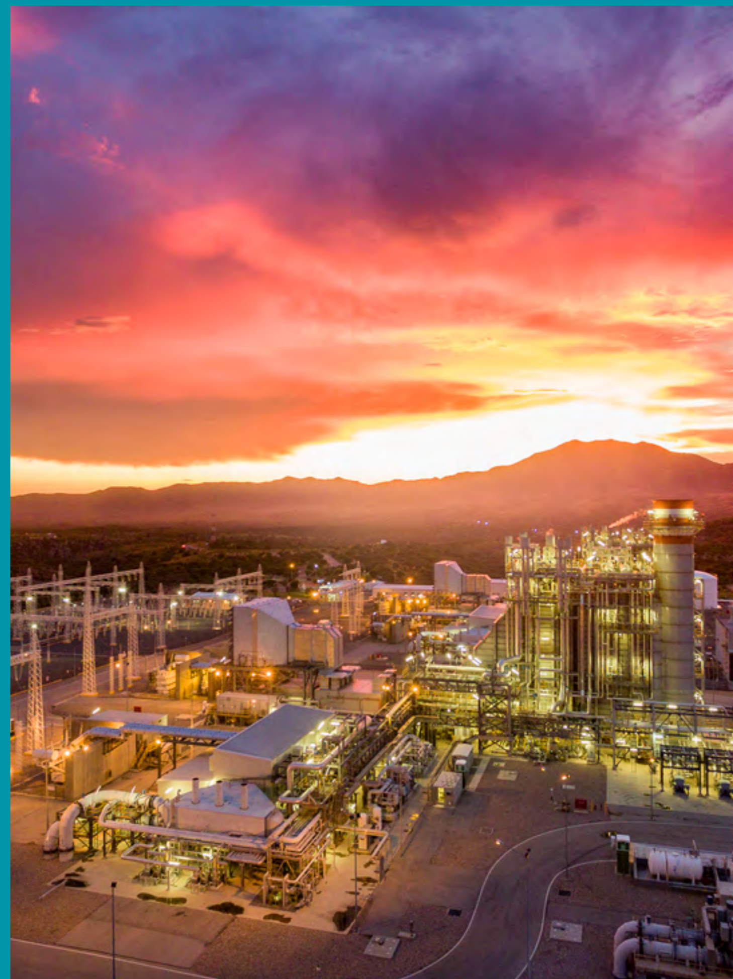
Planta de generación eléctrica de ciclo combinado, La Caridad, Sonora, México.
