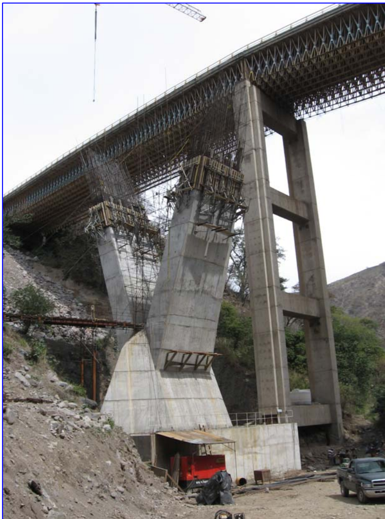
Construcción del apoyo central
