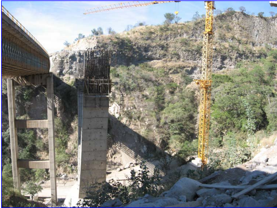
Apoyo central prácticamente terminado
