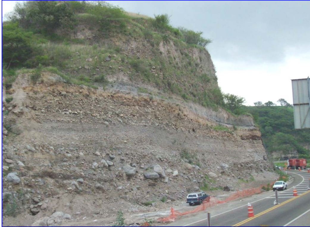
Corte en el lado Guadalajara – concluido –
