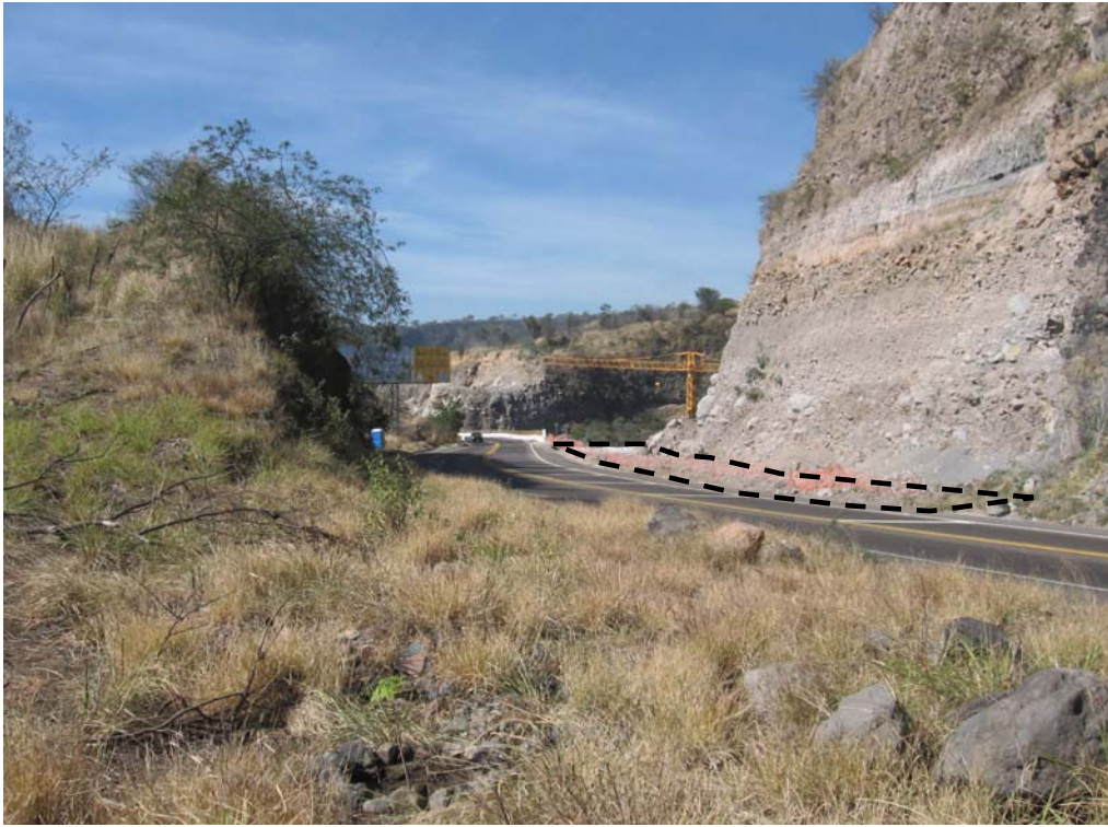
Camino de acceso lado Guadalajara, corte concluido al 100% Trabajos de despalme concluidos
