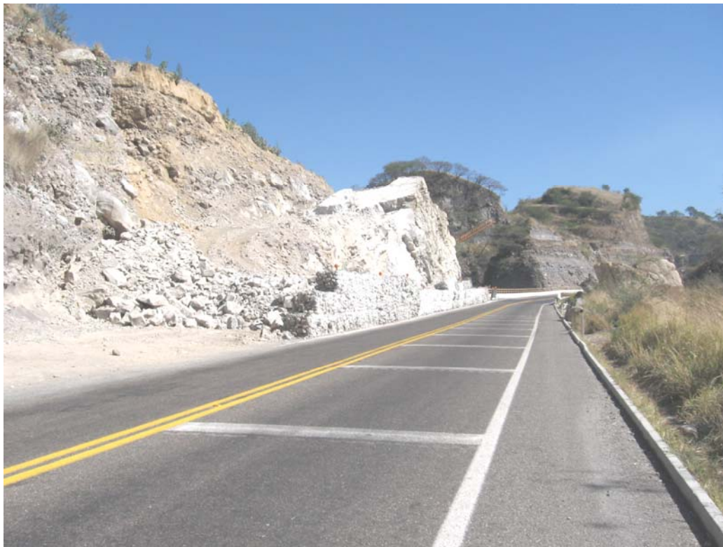
Corte Lado Colima - por concluir –
