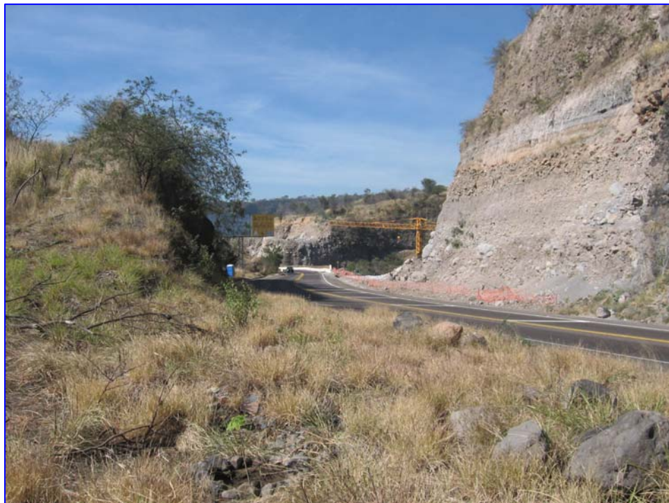
Vista del área de trabajo lado Guadalajara (se observa letrina instalada)
