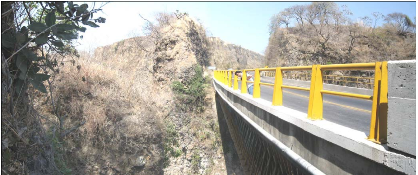
Vista de sur a norte
