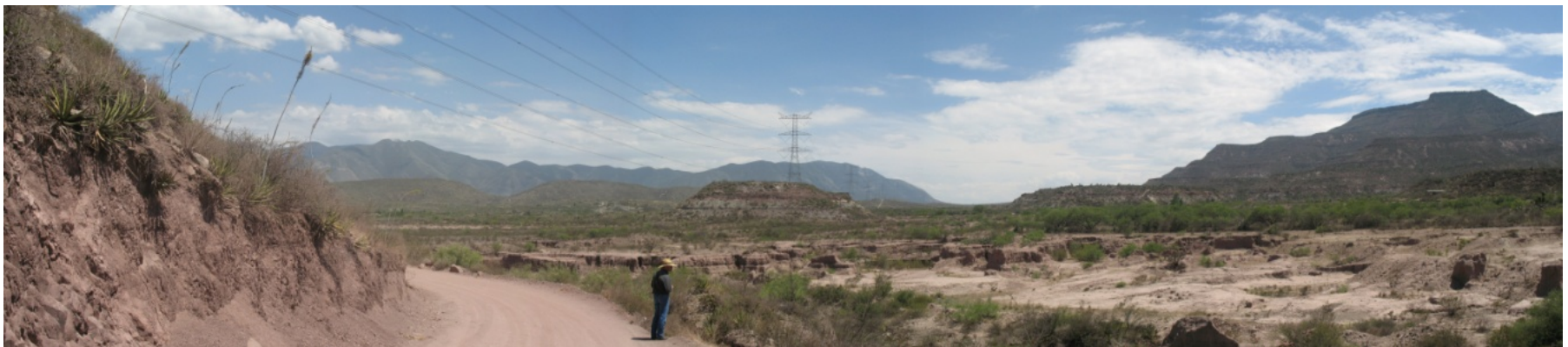
F.8. Los temporales km 14 + 300, vista hacia Saltillo. El trazo del nuevo tramo carretero pasa pegado al lomerío ubicado a la derecha (en segundo plano). Telón de fondo Mesa el Chiquihuite.
