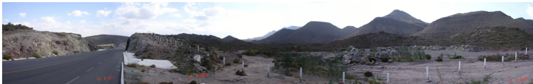
F.19. km 29+500 Vista hacia Saltillo del cuerpo del Libramiento construido.
