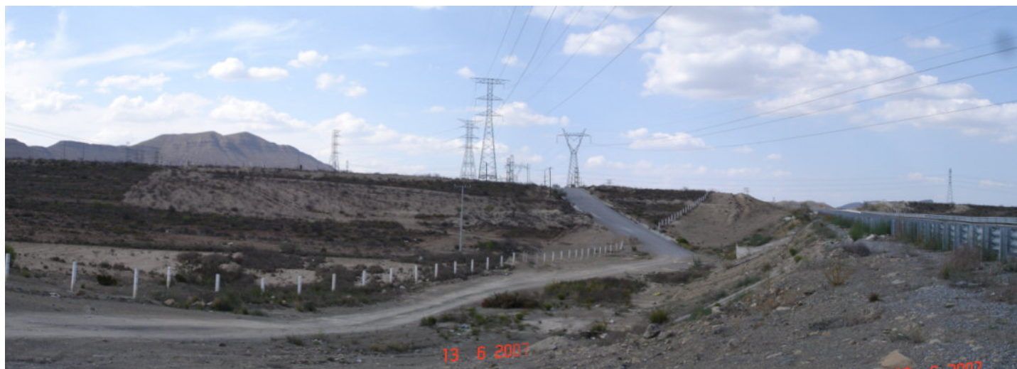
F.22. Vista hacia Saltillo desde tramo construido, cruce PSV km 35+500
