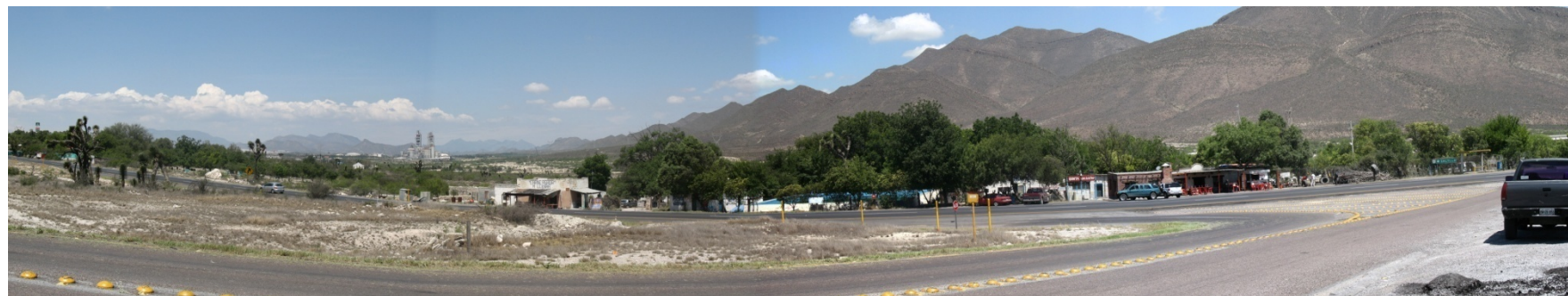
F.26. Sitio donde se emplazará el entronque Ojo Caliente, afectando viviendas y otros bienes diferentes a la tierra.
