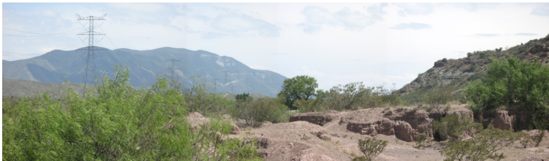
F.6. Vista detallada del km 13 + 935 del trazo en proyecto. Vista hacia Saltillo, al fondo en el extremo izquierdo la pequeña Sierra La Cuchilla Calabacillas delimita la cuenca visual al surponiente. Fuerte erosión como resultado de la extracción de material para la elaboración de ladrillo.
