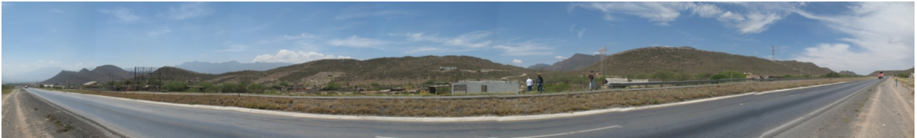
F.15. Sitio de emplazamiento del Entronque Torreón. Vista de la carretera hacia Torreón y Saltillo, asentamiento incipiente Padres Santos que será afectado con la construcción del entronque.
