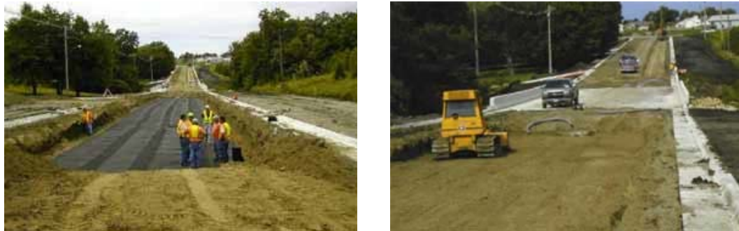
Fig. 7 Construcción de terracerías
