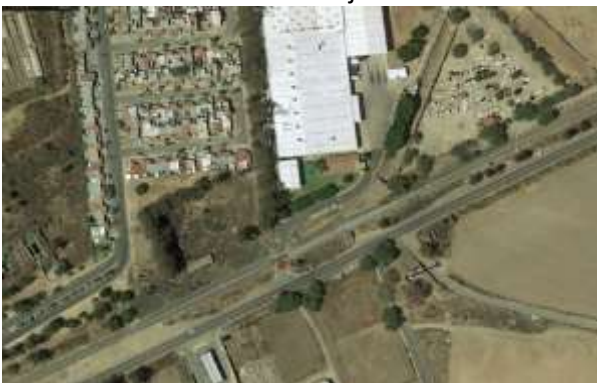
Acceso Fábrica Mega Empack
