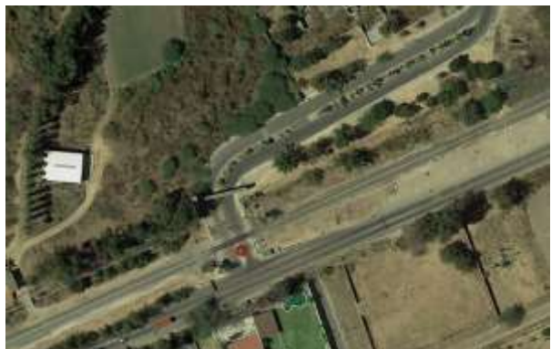
Acceso a Cima del Sol (Av. Almendro)
