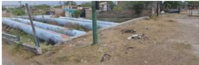
Ilustración 146 Acuaférico, en cruce vial: Calle Ferrocarril y Acueducto
