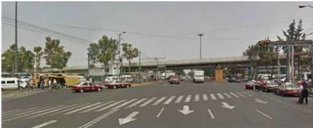
D. Calzada San Juan de Aragón (Entre Av 5 de Febrero y Av Ffcc Hidalgo)
