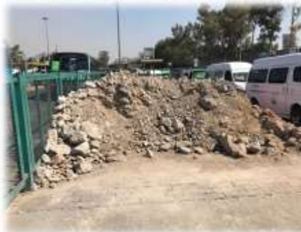
Escombros en andenes
