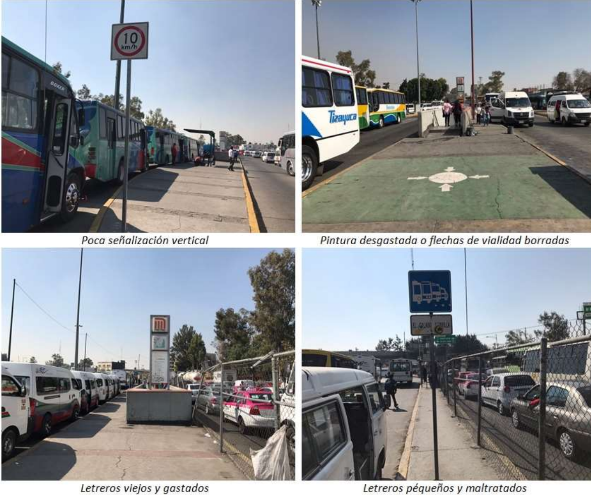
Figura 18 Estado actual del señalamiento
