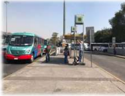
Las fisuras que se presentan en los andenes
