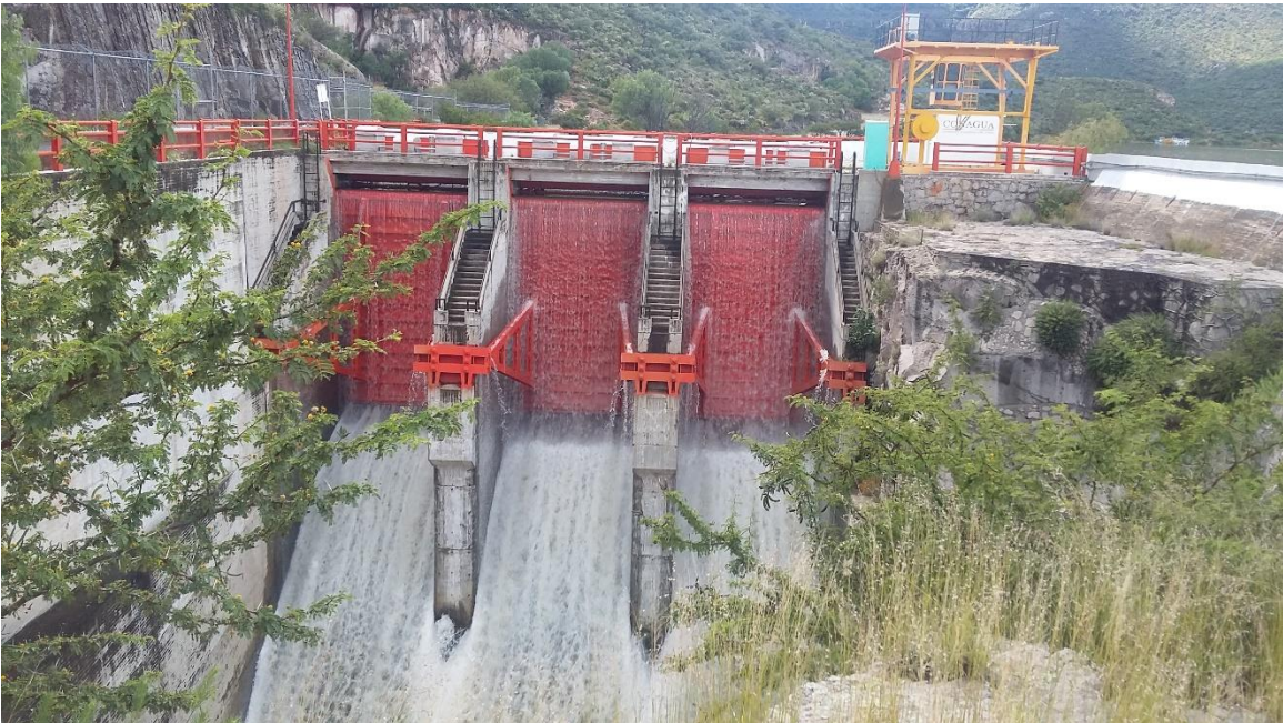
Figura 48. Funcionamiento de las compuertas laterales en la presa Guadalupe Victoria
