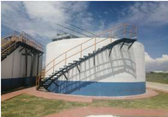
Digestor de lodos UASB
