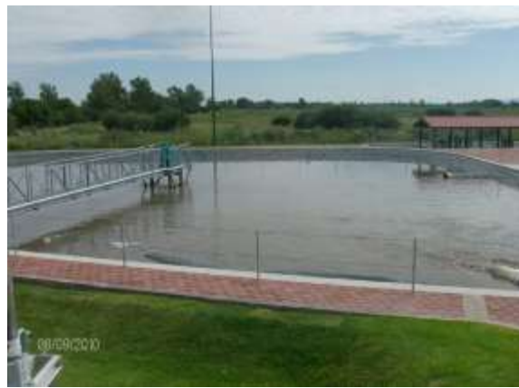
Tanque selector, reactor de lodos y clarificador
