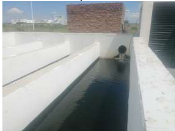
Cámara de contacto de cloro
