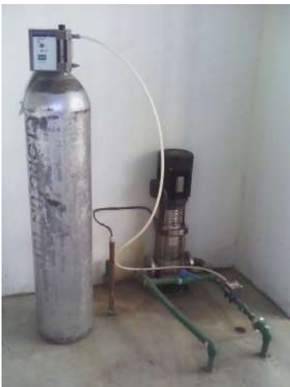
Sistema de cloración con gas cloro
