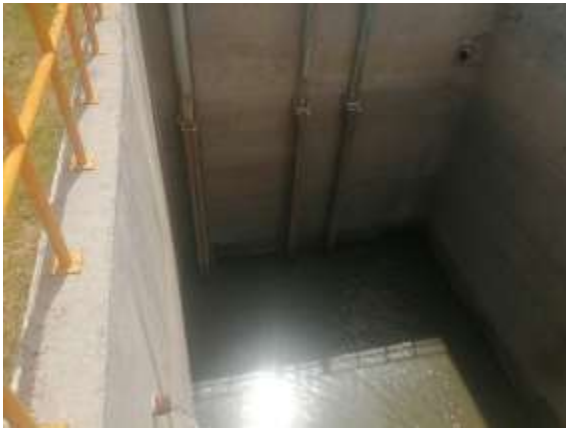
Cárcamo de bombeo del influente
