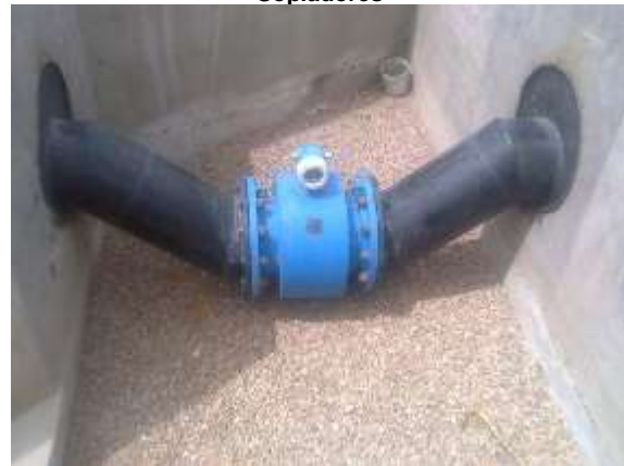
Medidor de flujo: Efluente
