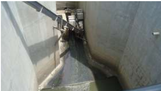
Área del pretratamiento: Cribas gruesas
