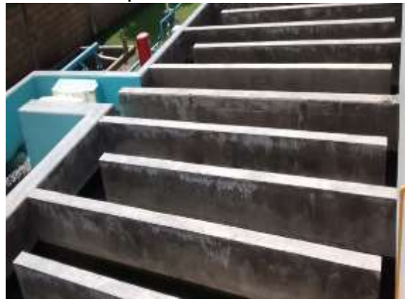
Canal de contacto de cloro
