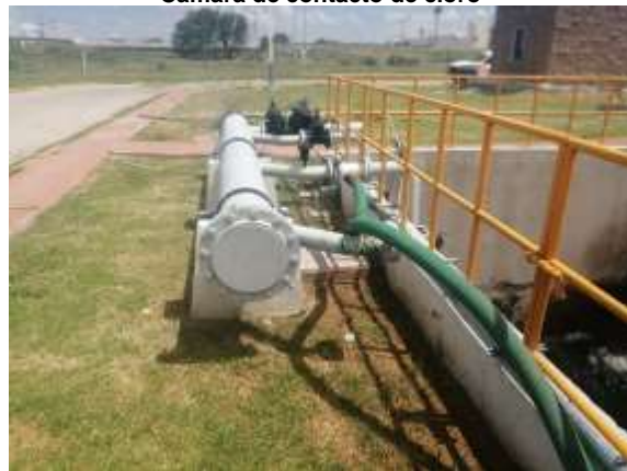
Medidor de flujo efluente
