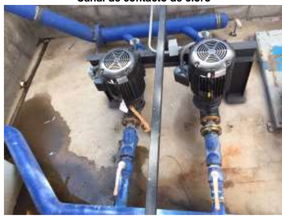
Equipo de bombeo para riego
