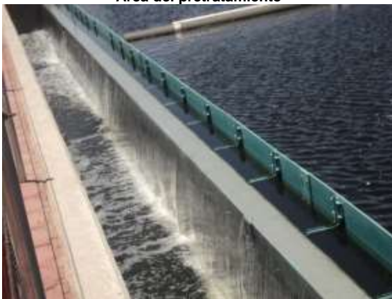
Tanque selector, reactor de lodos y clarificador
