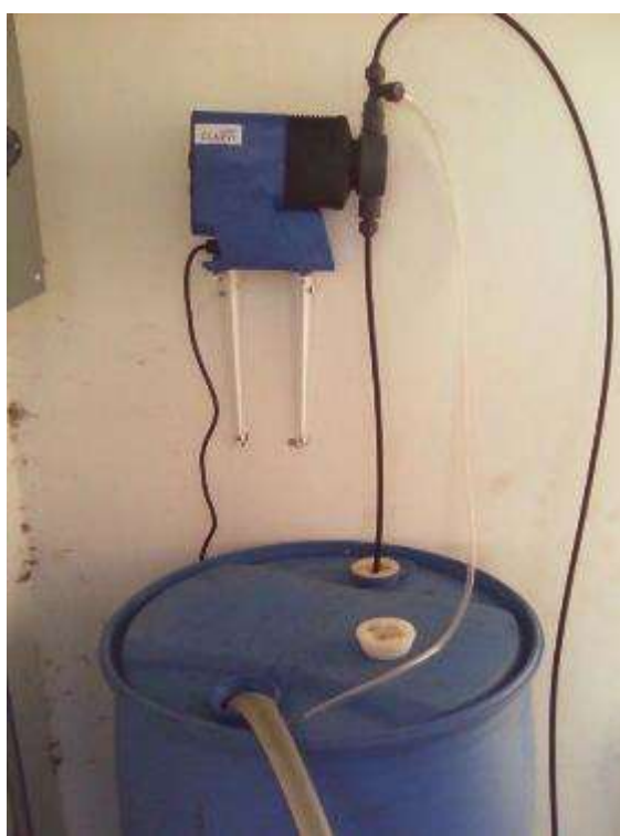
Sistema de cloración con hipocloradores
