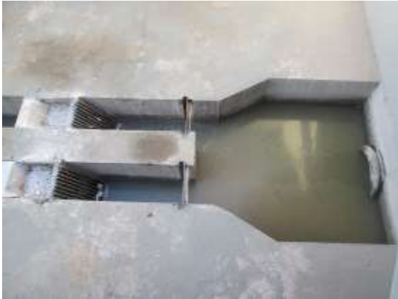
Área del pretratamiento: Cribas gruesas
