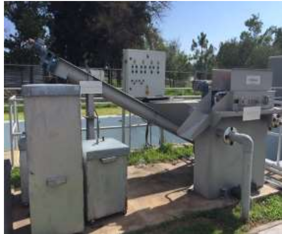
Área del pretratamiento: desarenadores
