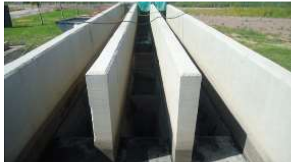
Área del pretratamiento: desarenadores
