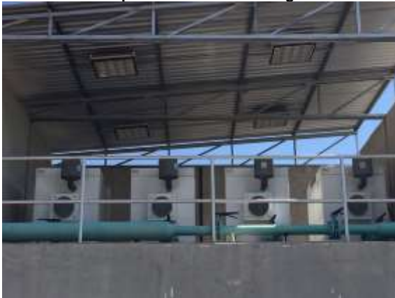
Área de sopladores
