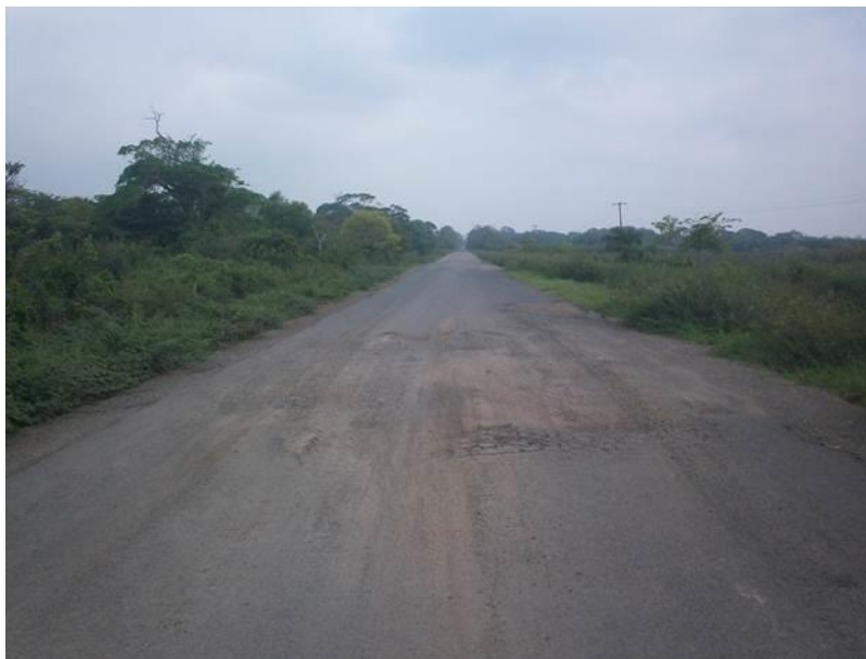
Figura 81. Deterioro en la carpeta asfáltica. Hundimiento perpendicular de la superficie de rodamiento. Corredor Tuxpan – Tampico por Tamiahua y La Laja.
