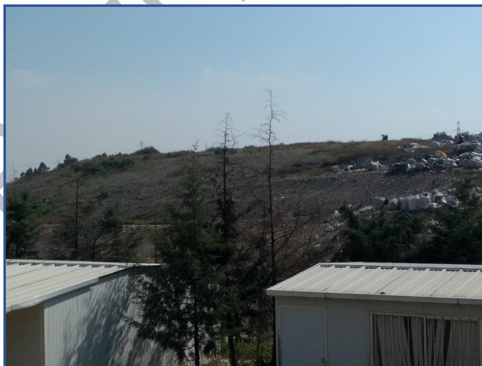
Figura 3. Superficie para la instalación del PV solar, vista Norte
