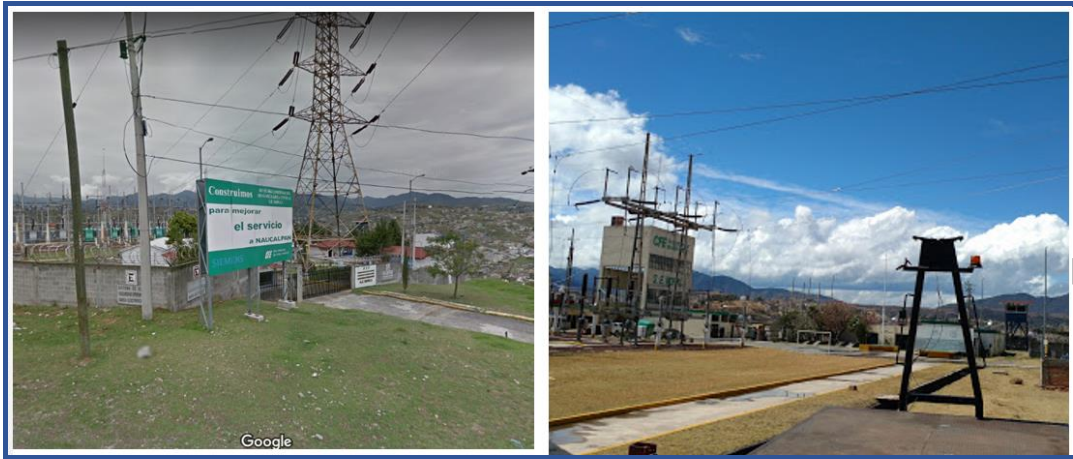
Figura 6. Subestación eléctrica Nopala
