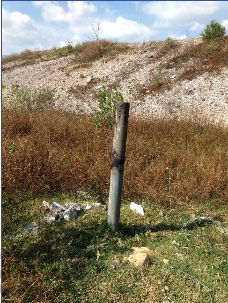
Figura 4. Pozo de venteo de biogás
