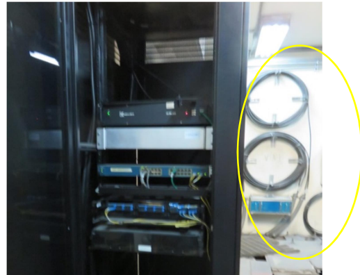
Rollos de fibra óptica dentro del local técnico no. 1
