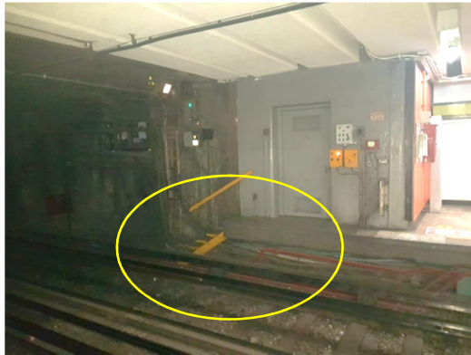
Fibra óptica salida del bajo andén hacia charolas
