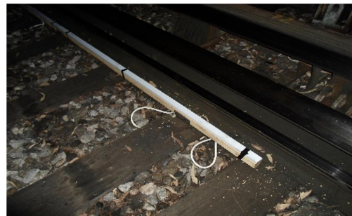
Tapiz madera instalado en cambio de vía
