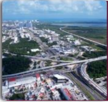
OBRAS DE CONTINUIDAD
